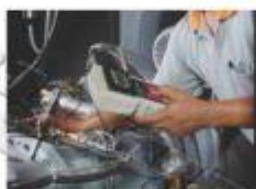
Комплексная система проверки состояния компрессора для поддержания «здоровой» работы систем
